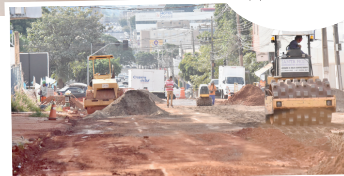
Equipe de reportagem constatou que alguns trechos estavam sem equipes trabalhando
